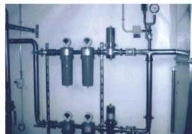
压缩空气系统: 监测干燥机, 以避免湿度造成系统损耗
